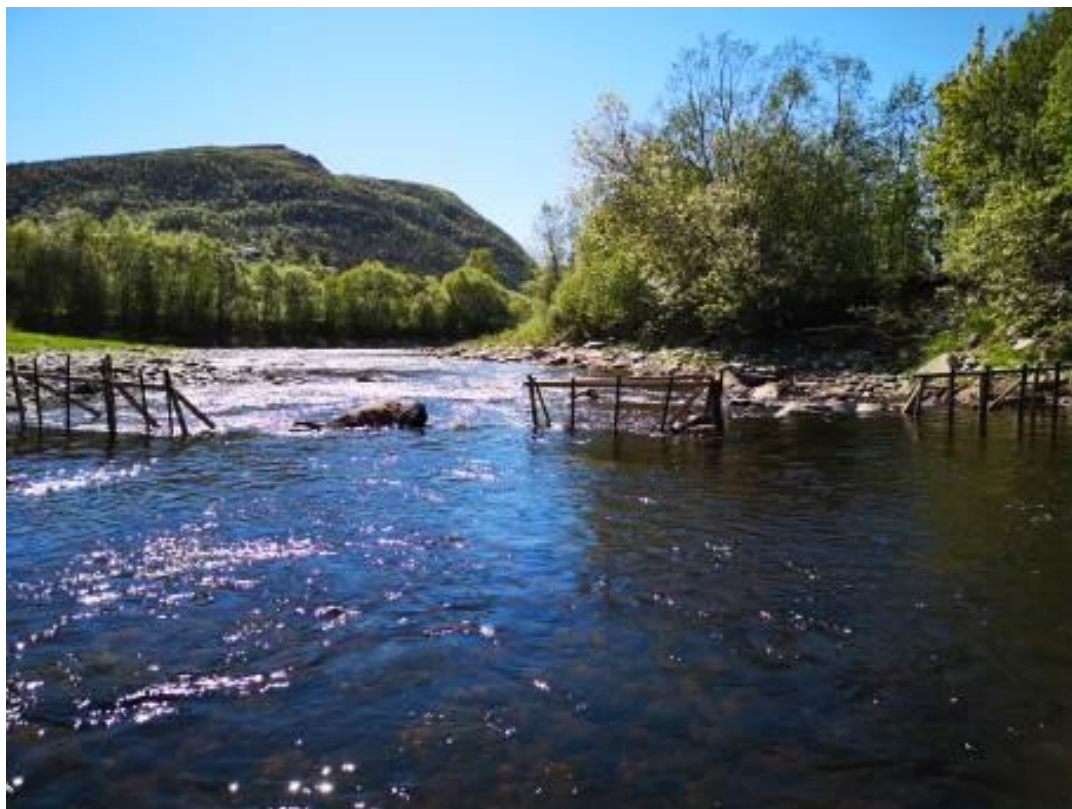
Figur 3. Overvåkingslokaliteten med ledegjerde for å snevre inn tverrsnittet. Dette ledegjerde ble modifisert i løpet av sesongen for å tåle høy vannføring.
